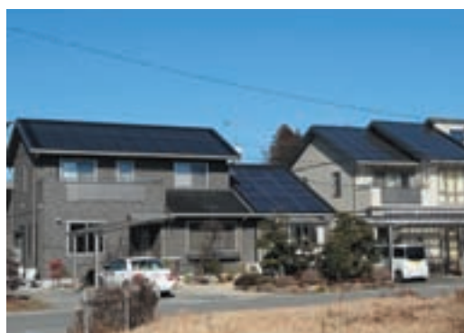
太陽光発電を設置している住宅
