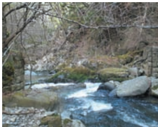
久米川発電所跡
