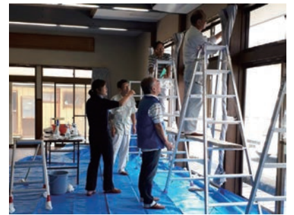
日赤による公共施設のガラス飛散防止フィルム張り
