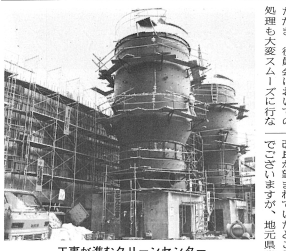
工事が進むクリーンセンター
