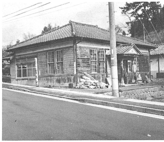
児童センター建設予定の旧図書館
