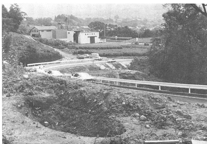
開発進むびるだ地籍電工取付道路
