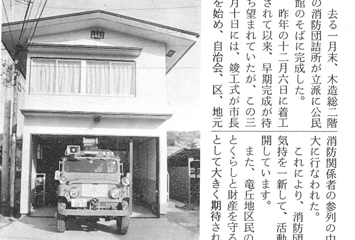
新築なった消防詰所
