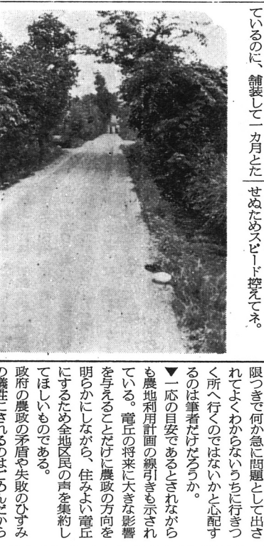
上川路地区の中村線改良工事の現場
