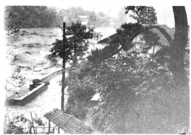
崩壊寸前の時又堤防
