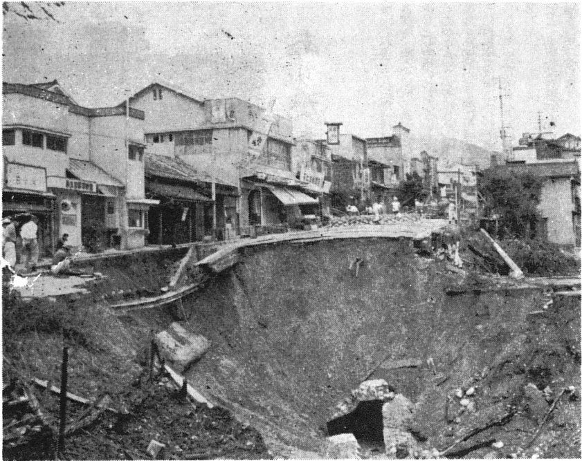
谷川線の大穴直径30M
