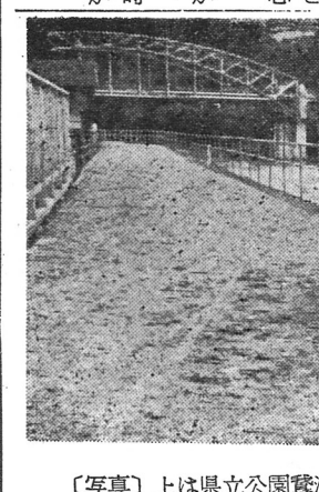
上は県立公園流流峡標識 下は天龍川護岸工事完了後の全景
